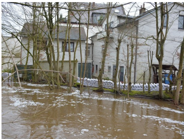
Dieses Haus in Reinbek musste mit Sandsäcken gegen die Fluten gesichert werden Foto: Elvira Nickmann / HA
